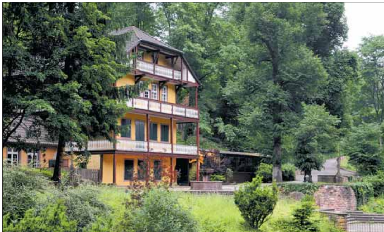
Da sich kein Pächter für die Gaststätte „Wolfsbrunnen“ gefunden hat, will die Stadt jetzt das Gebäude verkaufen. Für den ehemaligen Schloss-Koch, Wolf Schönmehl, war der Gemeinderat bereit, das Gebäude für 800 000 Euro sanieren zu lassen. Nachdem Schönmehl abgesprungen war, sollte der städtische Zuschuss nur noch 600 000 Euro betragen. Foto: Friederike Hentschel
