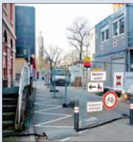
Gerade noch Platz für Fußgänger: Die Baustelle hinter der Krehl-Klinik. Foto: Alex
