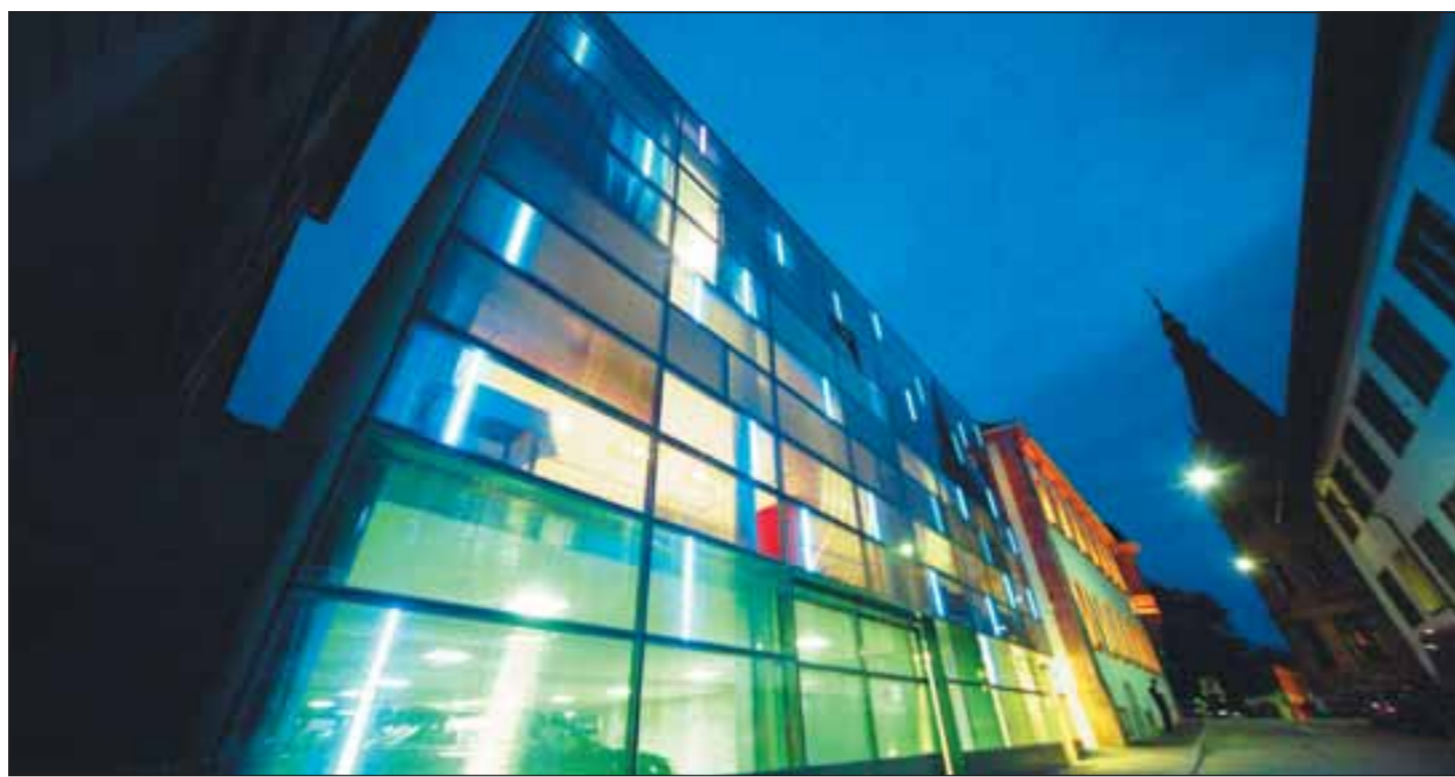
Einer der spektakulärsten Hotelneubauten der letzten Jahre in Heidelberg: das vor knapp vier Jahren fertiggestellte „Art-Hotel“ in der Seminarstraße, mitten in der Altstadt. Allerdings wurden mit den 24 Zimmern hier nicht die 700 bis 900 neuen Hotelbetten geschaffen, die das Hotelgutachten (siehe Stichwort rechts) mittelfristig für Heidelberg fordert. Foto: Joe
