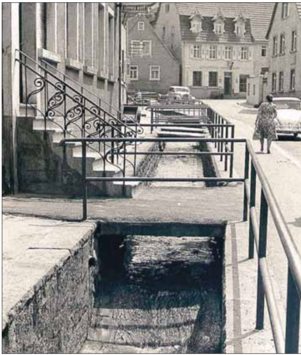
So wie vor 1962 wird es garantiert nicht mehr: Damals lag das Bachbett von der Rathausstraße aus gesehen sehr tief – und oft führte der Rohrbach wenig Wasser. In diesem Bereich soll es eine schmale Rinne geben, die nach dem Saulauf wieder in die Kanalisation mündet. Repro: Popanda
