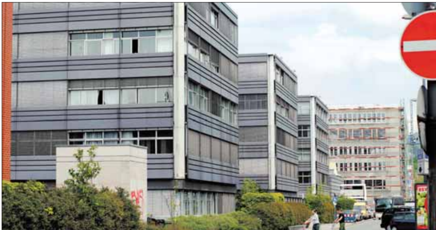
Spätestens im Frühjahr 2011 werden diese Gebäude zwischen Kurfürstenanlage und Bahnhofstraße abgerissen. Foto: Stefan Kresin
