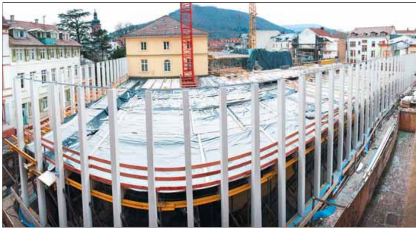
Ein bisschen wie ein Stelenfeld sieht die Theaterbaustelle momentan aus. Auf die zwölf Meter langen Balken werden die Decken gesetzt; wenn das Wetter nicht zu frostig wird, kann die Decke für die Werkstatt bis Weihnachten betoniert werden. Foto: Kresin
