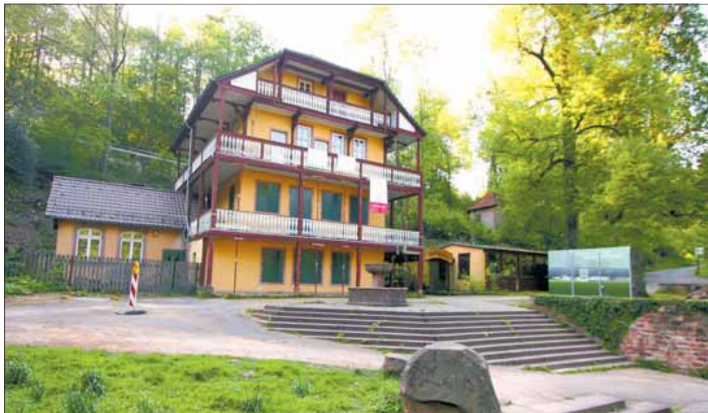
Wohl kaum ein Ort in Heidelberg ist so romantisch wie der Wolfsbrunnen. Sagen und Geschichten ranken sich seit der Römerzeit um diesen verwunschenen Ort. Jetzt wird das Haupthaus grundlegend saniert, die angrenzenden Gebäude werden ergänzt bzw. abgerissen. Foto: Joe
