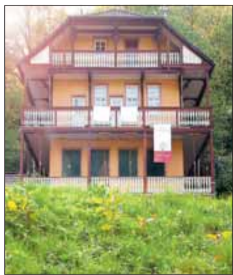
Der geschichtsträchtige „Wolfsbrunnen“ im Heidelberger Stadtteil Schlierbach wird komplett saniert. Spender werden gesucht. F.: Joe
