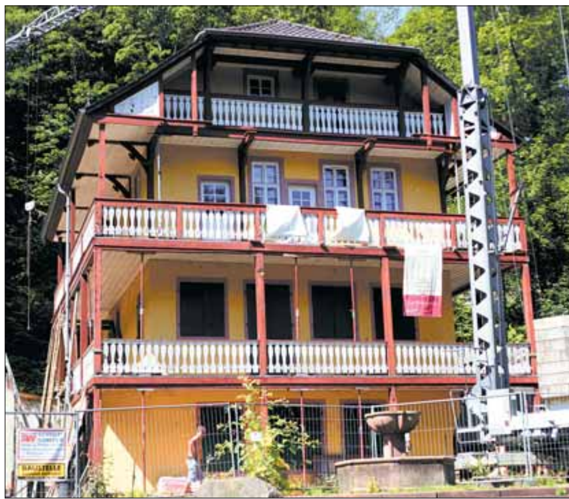
Allzu weit ist die Baustelle rund um den Wolfsbrunnen im Stadtteil Schlierbach noch nicht gediehen. Schuld daran war die Gefahr des Abrutschens des Hangs hinter dem historischen Gebäude. Nach entsprechenden Sicherungen gehen die Rohbauarbeiten weiter. Im nächsten Jahr soll der Innenausbau folgen. Fotos:Joe
